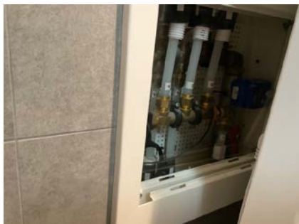
Rør-i rør skap, leilighet
