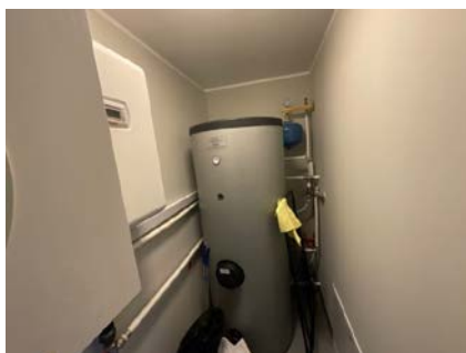
Varmtvannstank leilighet
