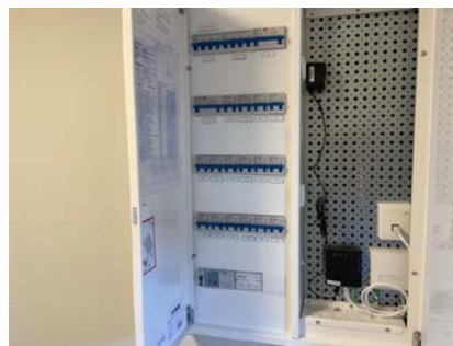
Sikringsskap bolig
