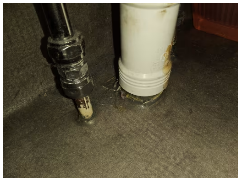
Bilde viser rørgjennomføring i gulv.
