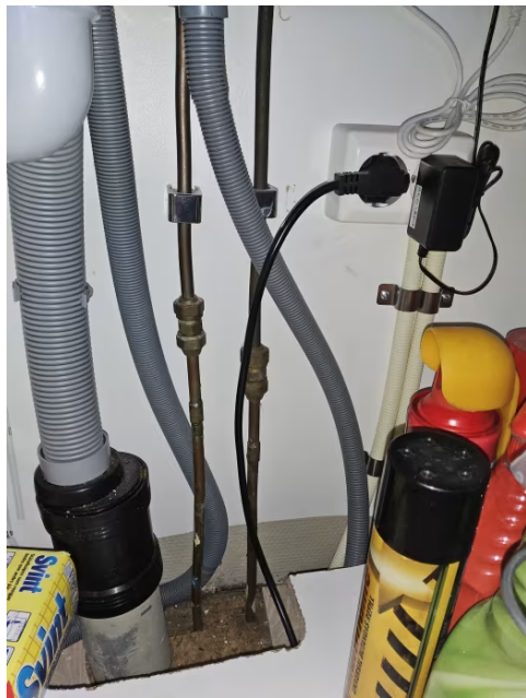
Bilde viser vannrør på kjøkken.
