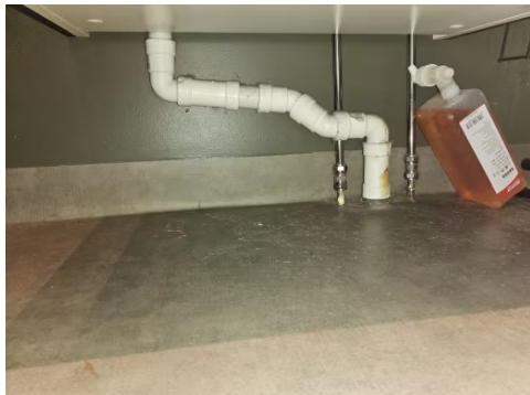
Bilde viser avløpsrør på bad.
