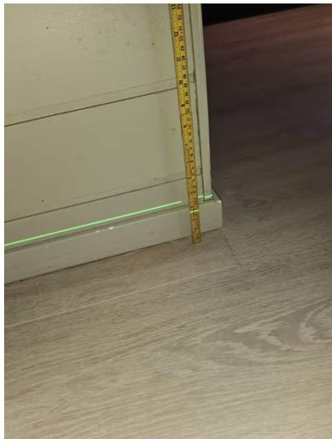
Bilde viser måling av etasjeskiller.
