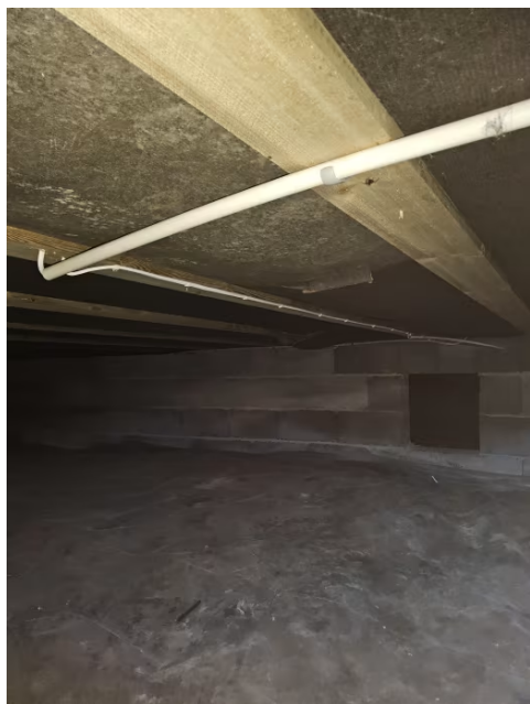
Bilde viser krypkjeller.
