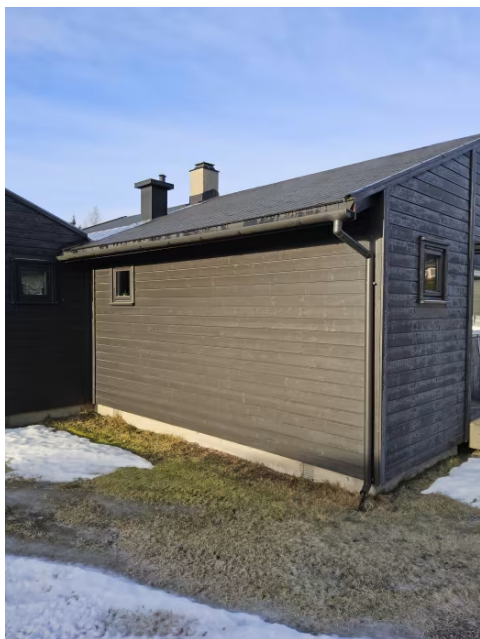
Bilde viser takrenner og taknedløp på sørfasade.
