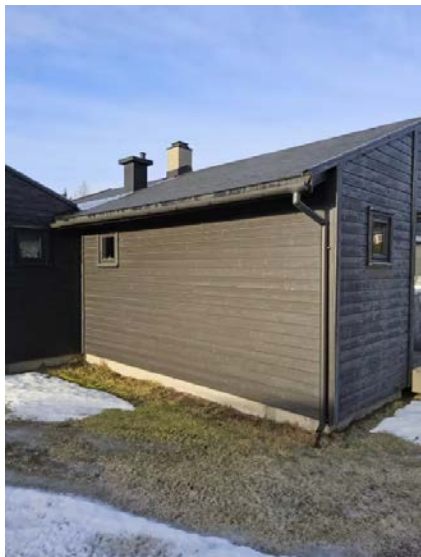
Bilde viser takrenner og taknedløp på sørfasade.
