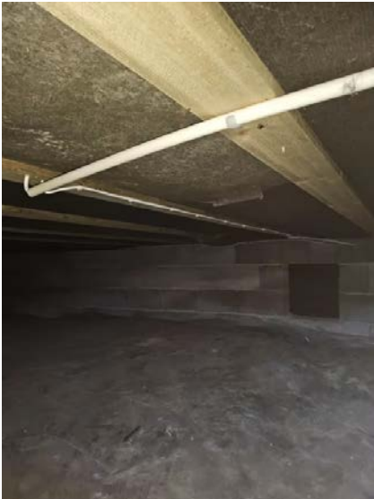
Bilde viser krypkjeller.
