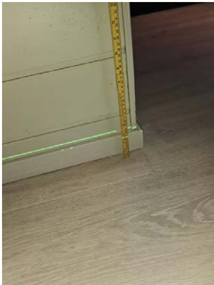
Bilde viser måling av etasjeskiller.
