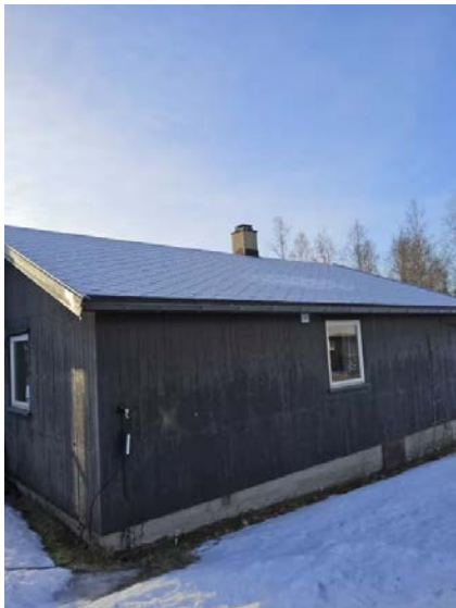
Bilde viser taktekkning.
