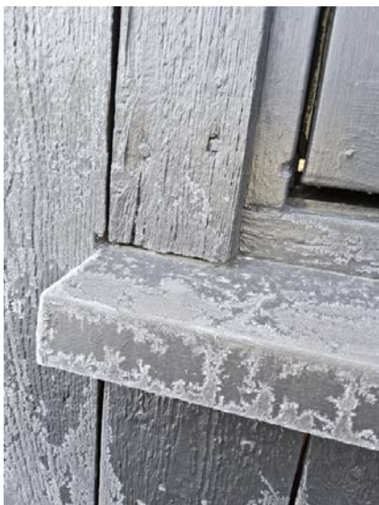
Bilde viser omramming mot vannbrett.
