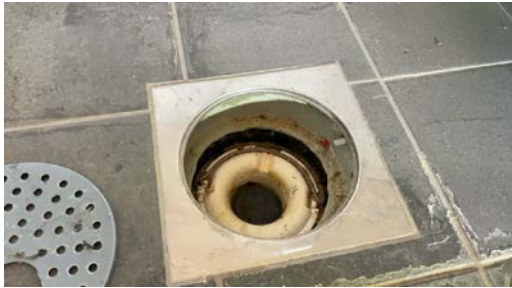
Sluk i gulv.
