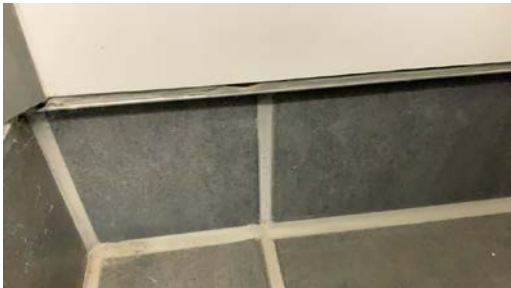
Glipp i Silicontetting i nedre kant av våtromsplater.
