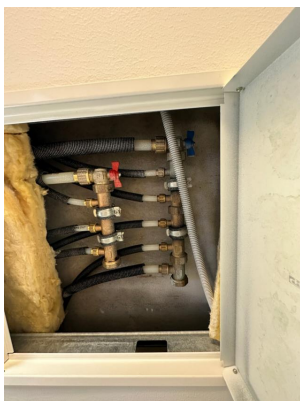
Samleskap med rørkurser og stoppekraner
