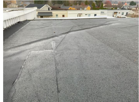
Ufagmessig utførelse av takpapp.
