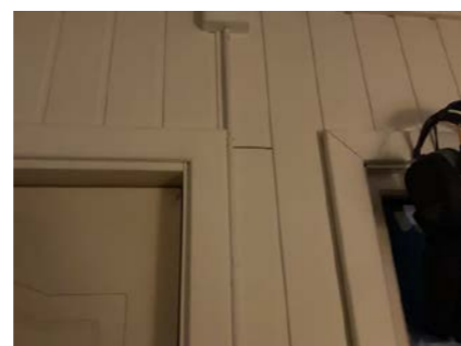
Sår/skade i plate. For langt saget.
