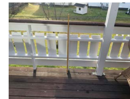
Rekkverk er målt til ca 91cm.
