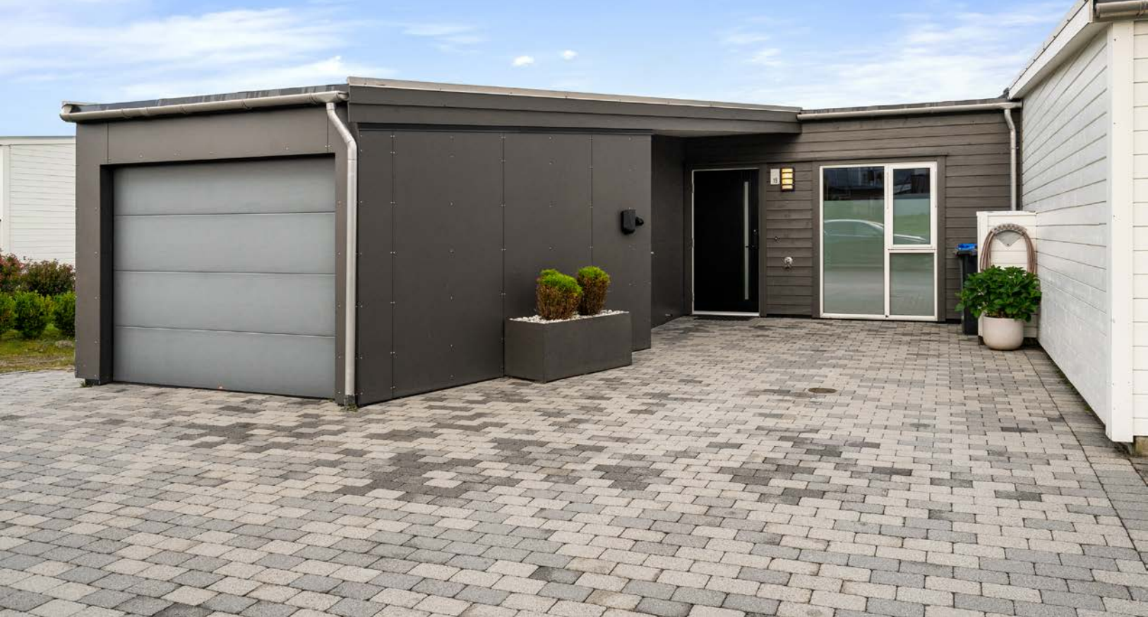
Boligen er oppført i 2014, går over to plan og ligger i et nyetablert og barnevennlig område
