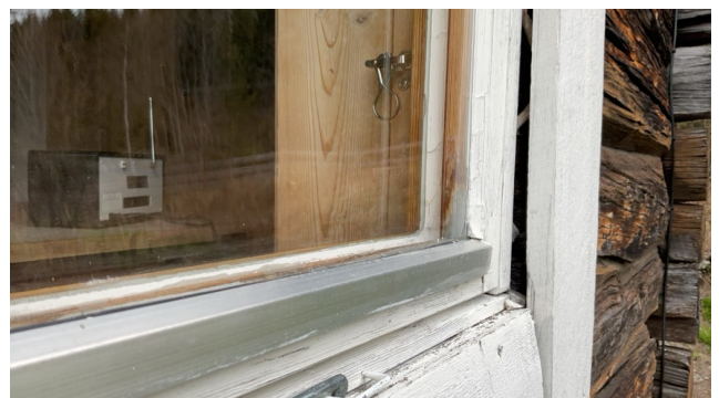
Åpning i overgang belistning
