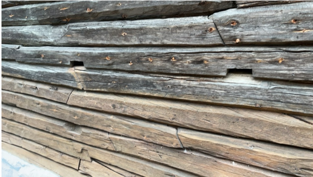
Stedvis åpninger i loft
