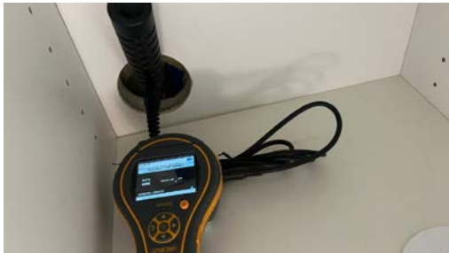
Fuktmåling i vegg mot badet
