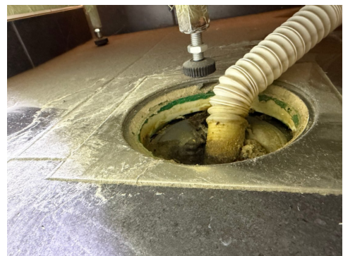
Plastsluk i dusjsone.
