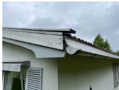
Vindski med skade.
