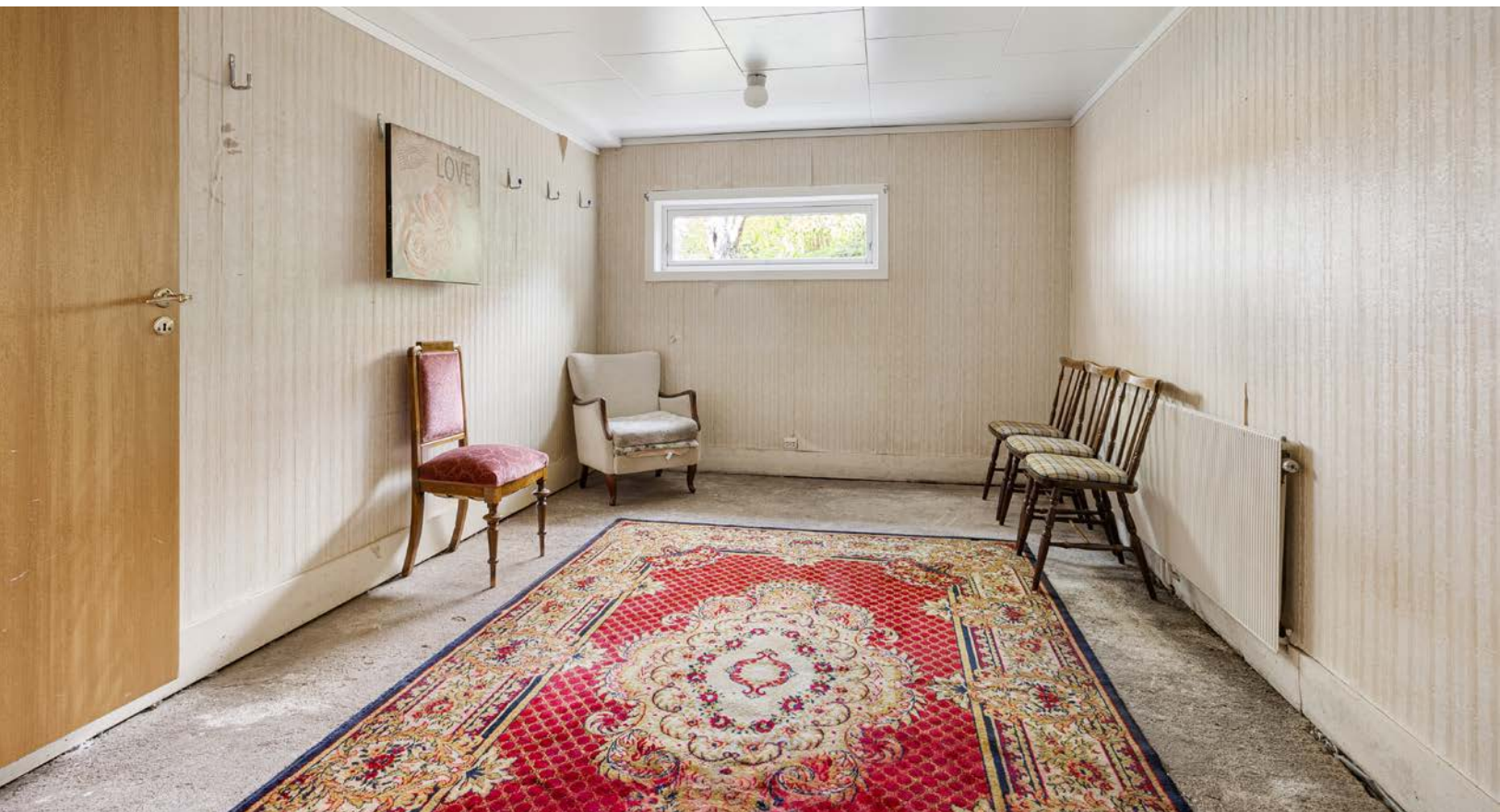
Soverom og innredet rom i underetasjen fremkommer som et stort rom benevnt som stue på byggetegninger. Etter deling er dette rommet å anse som et innredet rom og ikke et oppholdsrom.
