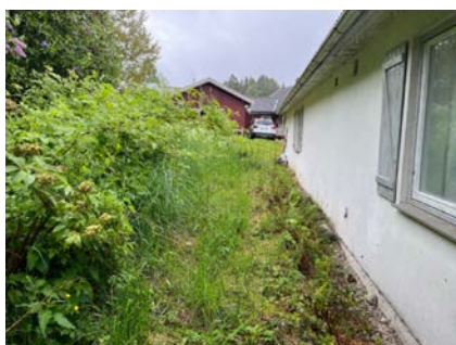
Terreng faller mot bygning fra øst.
