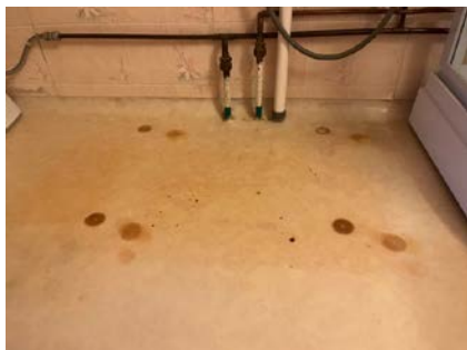
Falmet og varmemerker på belegg.
