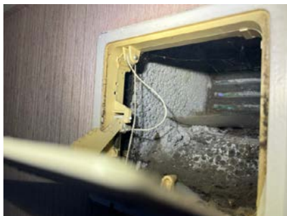
Veggventil i tilbygg viste vegg av lettklinkerblokker.
