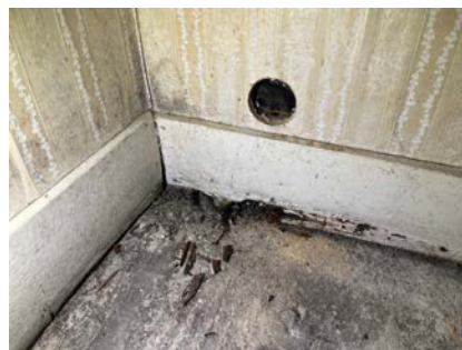
Fukt og råteskader i kjellerstue.
