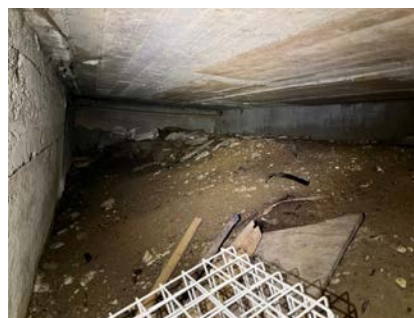
Krypkjeller med jordmasser.
