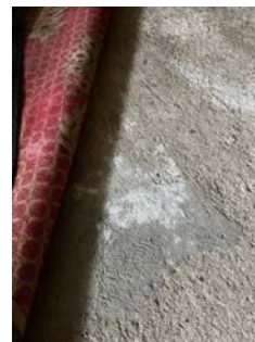
Fukt og råteskader i kjellerstue.
