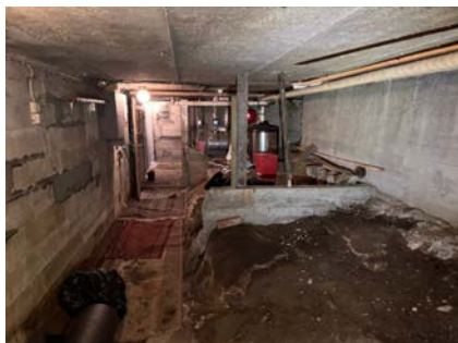
Det er skrånet fjell fra øst med innsig av vann.
