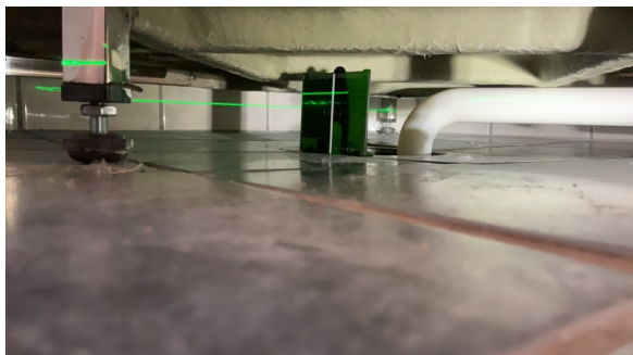
Målt fall til sluk: 9mm
