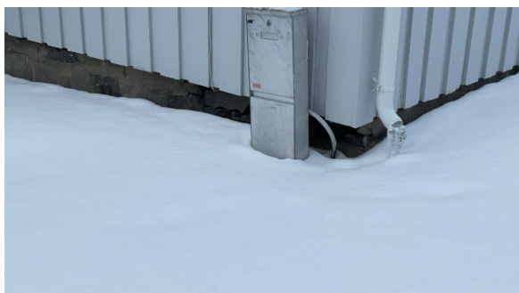
Gråsteinsmur på store deler av bolig.
