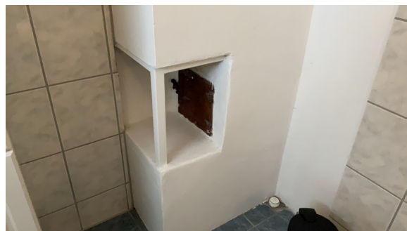
Sotluke plassert på bad
