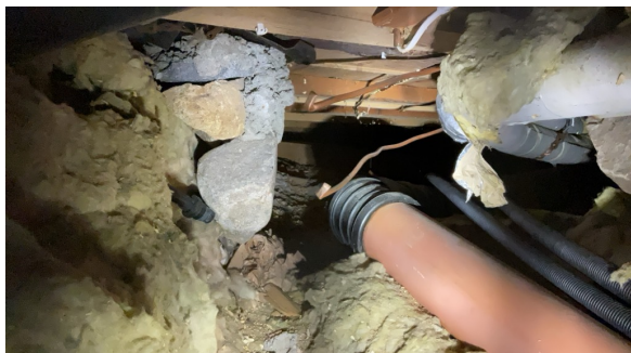
Krypekjeller under gang.
