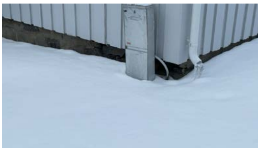
Gråsteinsmur på store deler av bolig.
