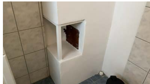
Sotluke plassert på bad
