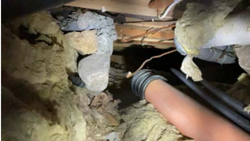
Krypekjeller under gang.
