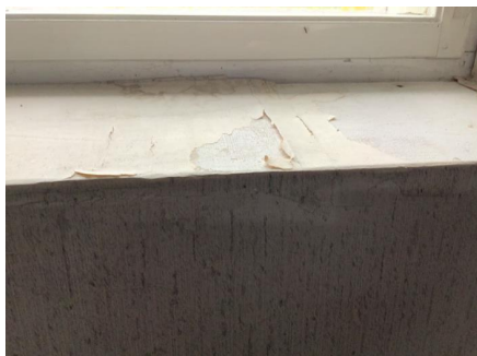
Hulltaking, og det måles skadelig fuktinnhold.
