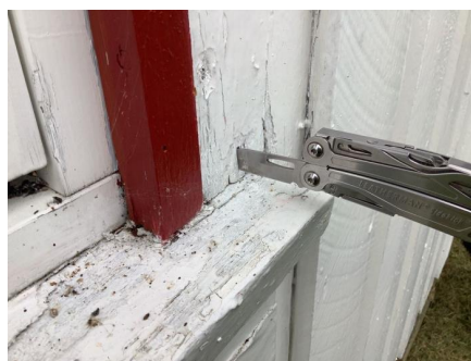
Omramming er ført helt ned til vannbrett.
