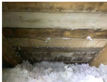
Det er isolert tett mot taktro, uten lufting fra takfot.
