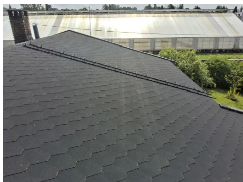
Det er etablert takstige på taket.
