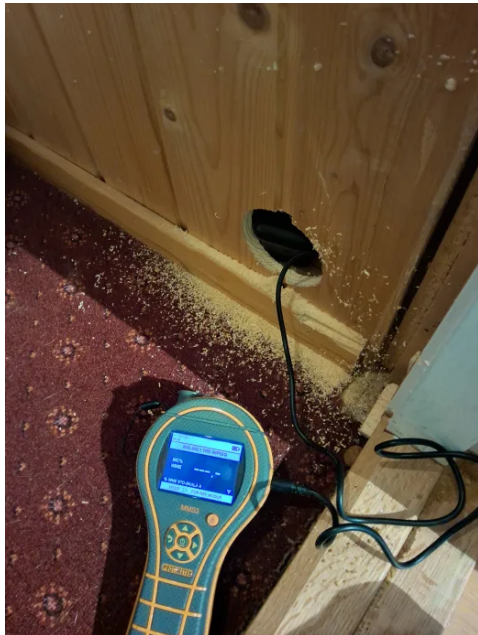
Bilde fra fuktmåling i veggkonstruksjon tilstøtende våtsone.
