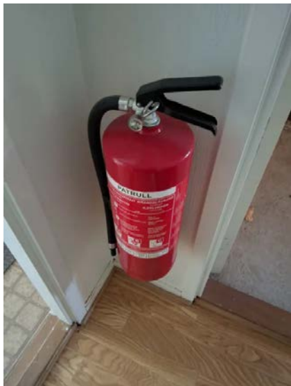
Vegghengt brannslukningsapparat.
