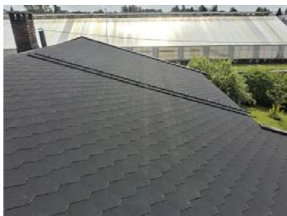
Det er etablert takstige på taket.
