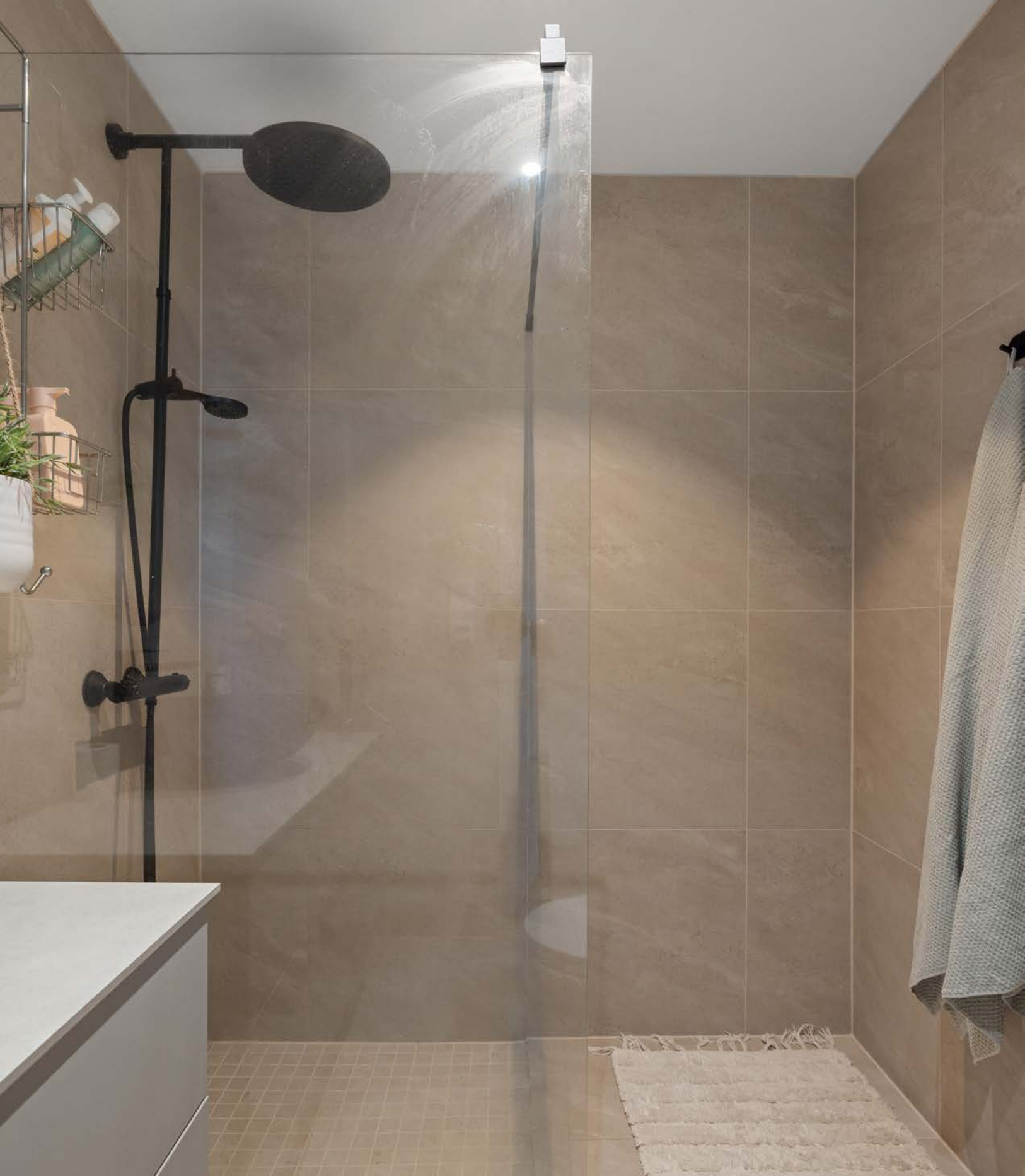
Dusjnise med dusjvegg og veggmontert dusjbatteri med regnfall.
