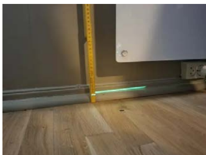
Etasjeskiller er kontrollert med nivelleringslaser.
