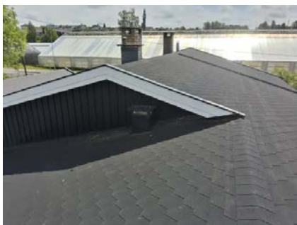
Boligen er oppført med saltak.
