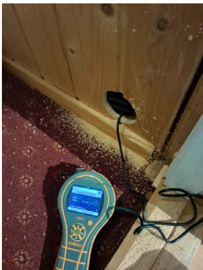
Bilde fra fuktmåling i veggkonstruksjon tilstøtende våtsone.
