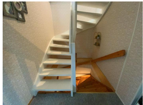
Besiktigelse av trapp.
