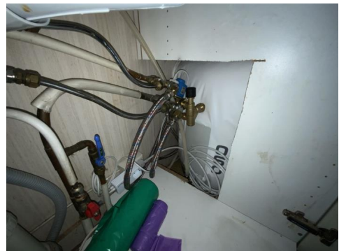
Besiktigelse av bereder.
