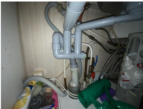
Besiktigelse av rørpropplegg.
