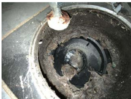
Kontroll av sluk.
