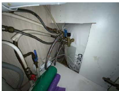
Besiktigelse av bereder.
