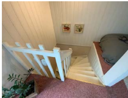
Besiktigelse av trapp.
