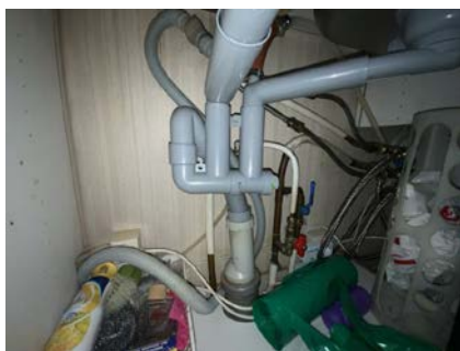
Besiktigelse av røropplegg.
