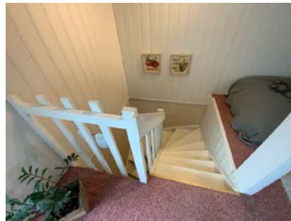
Besiktigelse av trapp.
