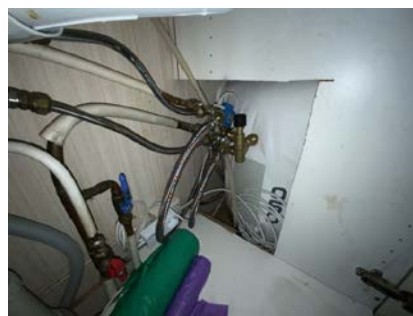
Besiktigelse av bereder.
