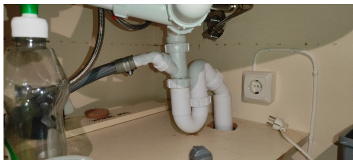
Kontroll av røropplegg.
