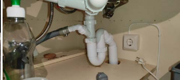
Kontroll av røropplegg.
