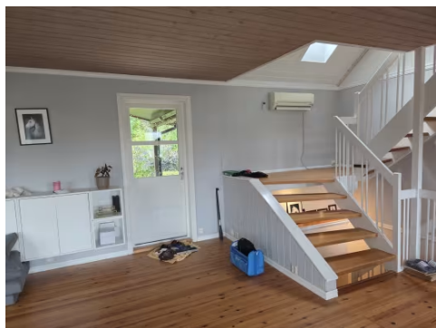
Rekkverk mangler.
