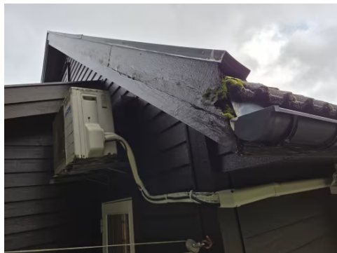
Råteskadet vindski.
