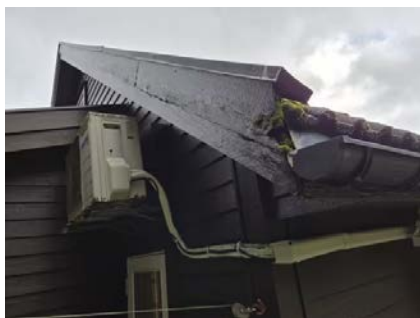
Råteskadet vindski.
