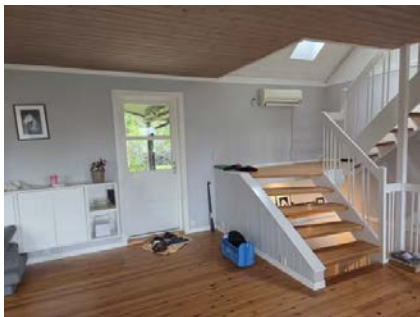
Rekkverk mangler.
