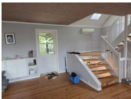
Rekkverk mangler.
