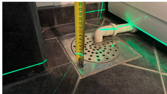
Kontroll av fallforhold.
