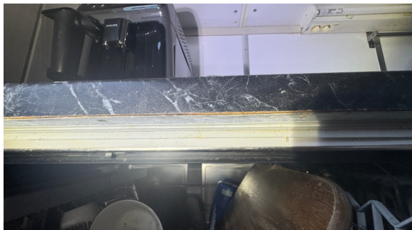
Fuktsvell i benkeplate over oppvaskmaskin
