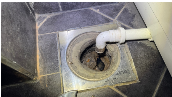
Kontroll av sluk.
