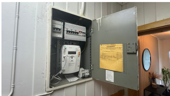
Kontroll av el-skap og kursfortegnelse.
