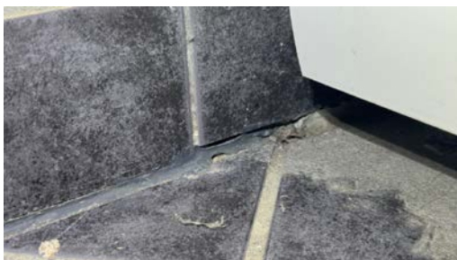
Sprekker i fug mellom vegg/gulv.-
