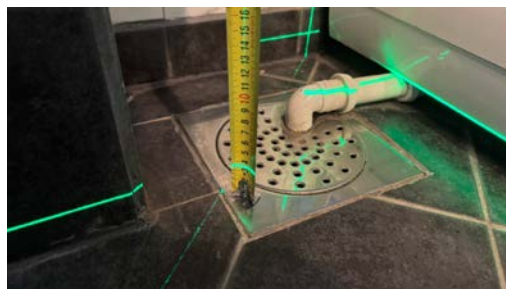
Kontroll av fallforhold.
