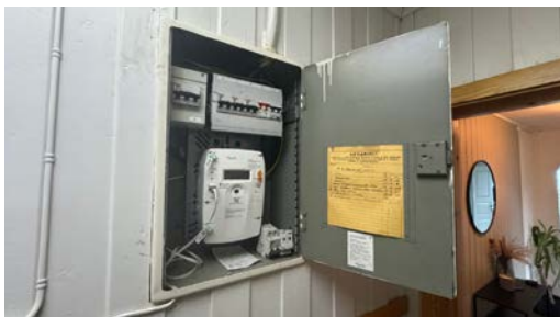
Kontroll av el-skap og kursfortegnelse.
