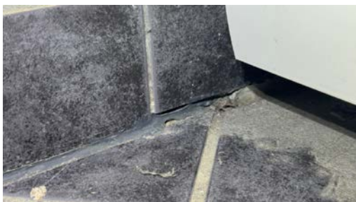
Sprekker i fug mellom vegg/gulv.-
