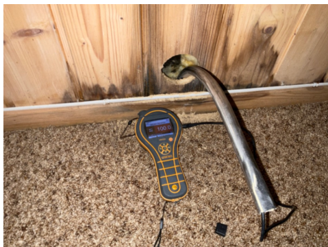
Hulking i utfore kjellervegg 9. mars 2026
