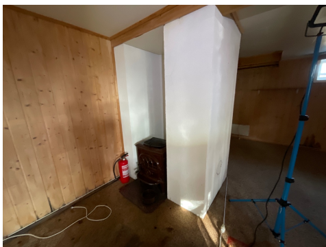
Vedovn, pipe og feieluke i kjellerstue
