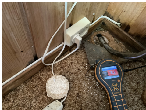
Hulltaking i oppforet kjellergulv 9. mars 2026
