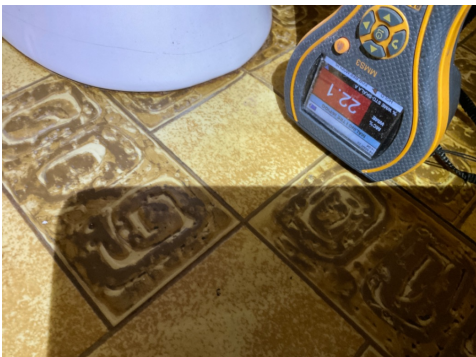
Fuktmåling i gulvverflate
