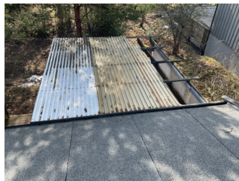
Plastplater på terrasseoverbygg
