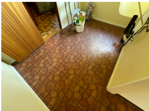
Gulvoverflate på vaskerom
