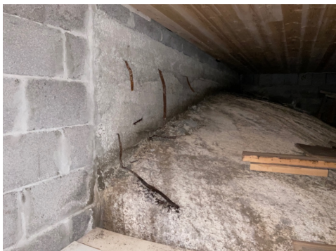
Fundamentering på fjell i krypkjeller
