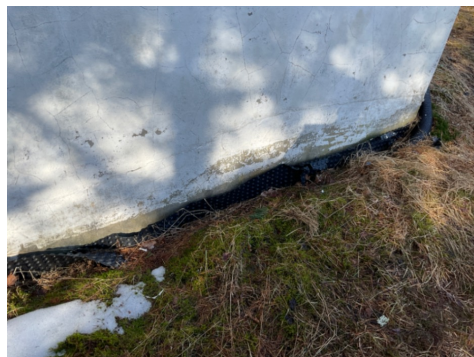
Synlig knotteplast på grunnmur
