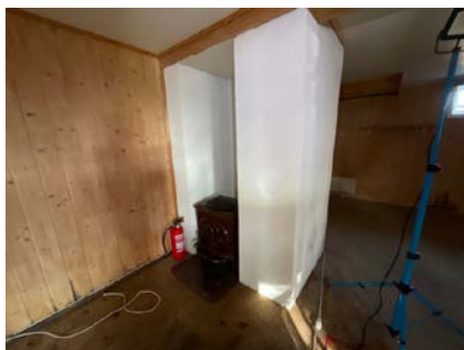
Vedovn, pipe og feieluke i kjellerstue
