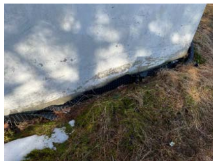
Synlig knotteplast på grunnmur
