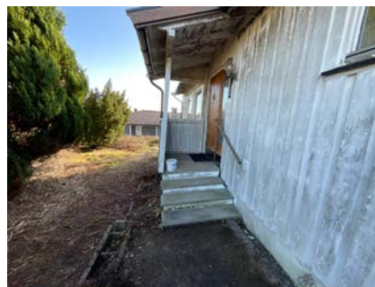
Utvendig trapp ved inngangsparti
