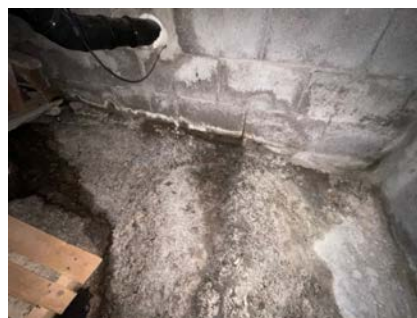
Synlig vann inn på fjell i krypkjeller
