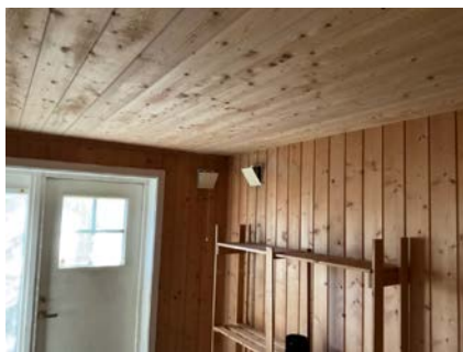
Lufteventiler i vegg i kjeller
