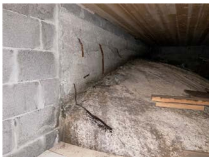
Fundamentering på fjell i krypkjeller
