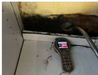
Hulltaking i kjøkken vegg 9. mars 2026
