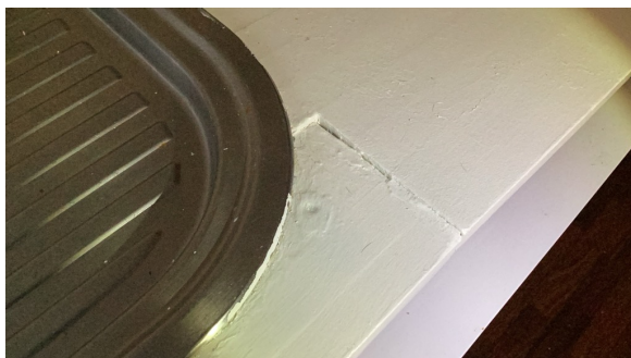
Skjøl på benkeplate
