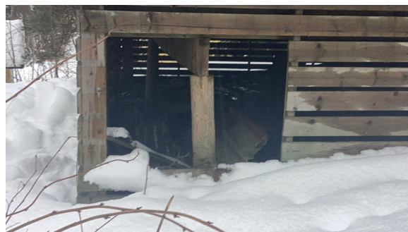
Fundamentering av veranda.
