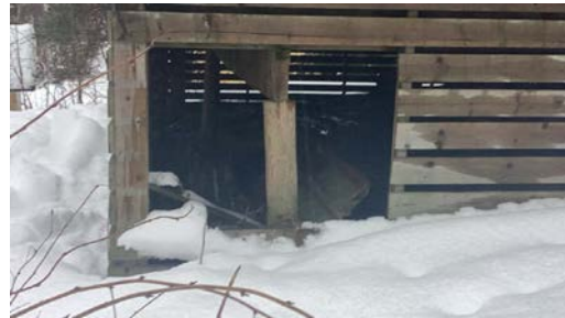
Fundamentering av veranda.
