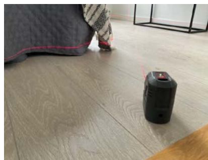
Nivellering soverom, avvik
