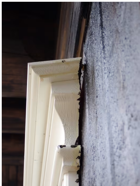
Utførelse på omramming over vindu/dør.
