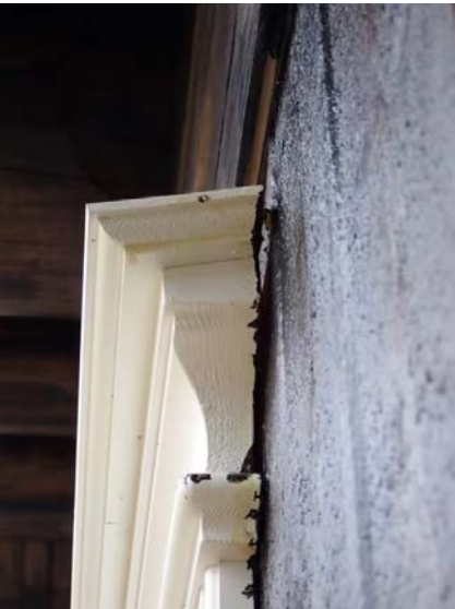
Utførelse på omramming over vindu/dør.
