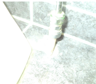
Usikker rørgjennomføring i gulvet.
