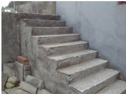
Utvendig støpt trapp til kjeller.
