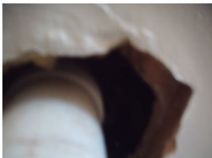
Fuktmåling i underliggende himling ved vegg i mellom kjøkken og bad.
