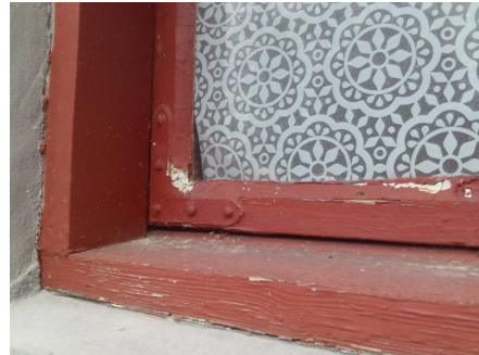
Eldre opprinnelige kjellervinduer
