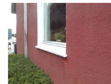
Deler av fasade med vannbord for vindu
