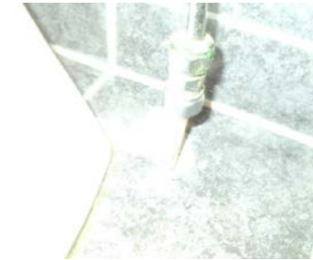
Usikker rørgjennomføring i gulvet.
