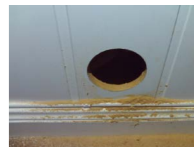
Hulltaking i utford vegg.
