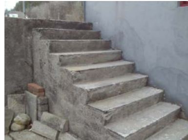
Utvendig støpt trapp til kjeller.
