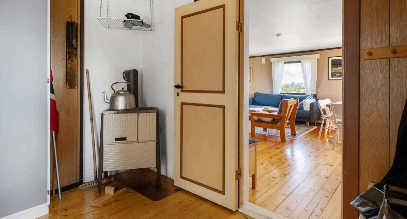
Gangen har lakkerte tregulv og det er oppbevaringsplass i plassbygde garderobeskap. I hjørnet av rommet er det en eldre vedovn med for liten ubrennbar plate på gulv.
