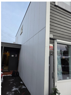
Steni plater etablert på nordvegg.
