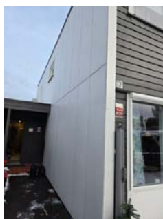
Steni plater etablert på nordvegg.
