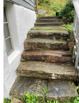
Stein- og betongtrapp til inngang
