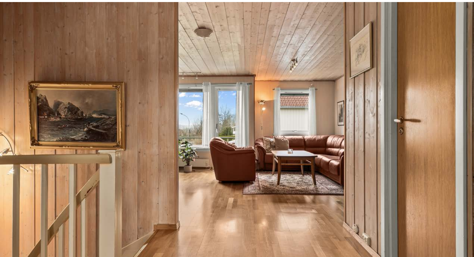
Varmpumpe plassert i trappeoppgang.
