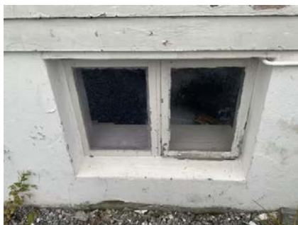
Kittfalsler (utvendig tetting mellom vindusramme og glass) er uttørket og stedvis løsnet.
