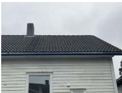
Mer enn halvparten av forventet brukstid er passert på undertak og taktekingen. Tekkingen har mose og slitasje på grunn av elde.
