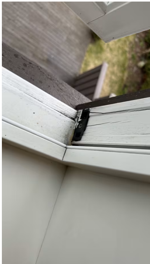
2. etasje Vindu på soverom mot sør.
