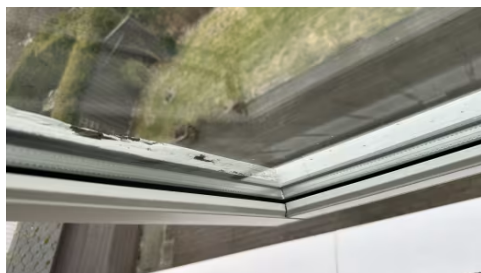
2. etasje Vindu på soverom mot sør.
