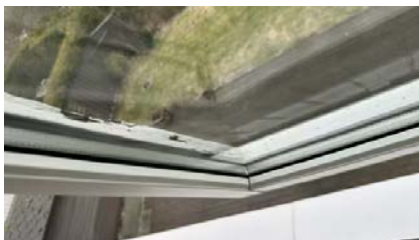
2. etasje Vindu på soverom mot sør.
