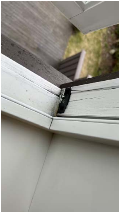
2. etasje Vindu på soverom mot sør.
