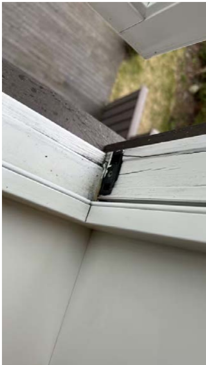
2. etasje Vindu på soverom mot sør.
