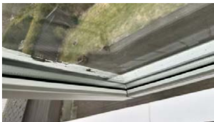
2. etasje Vindu på soverom mot sør.
