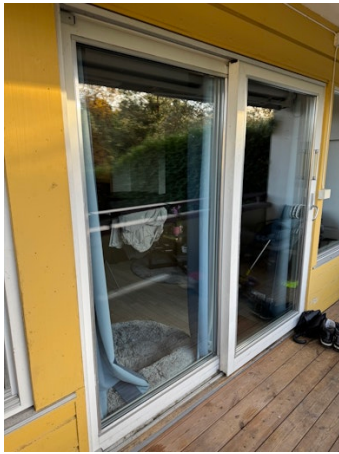
Oversiktsbilde over skyvedør
