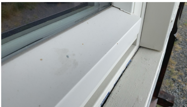
Anbefales vannbrettbeslag med fall utfra vindu
